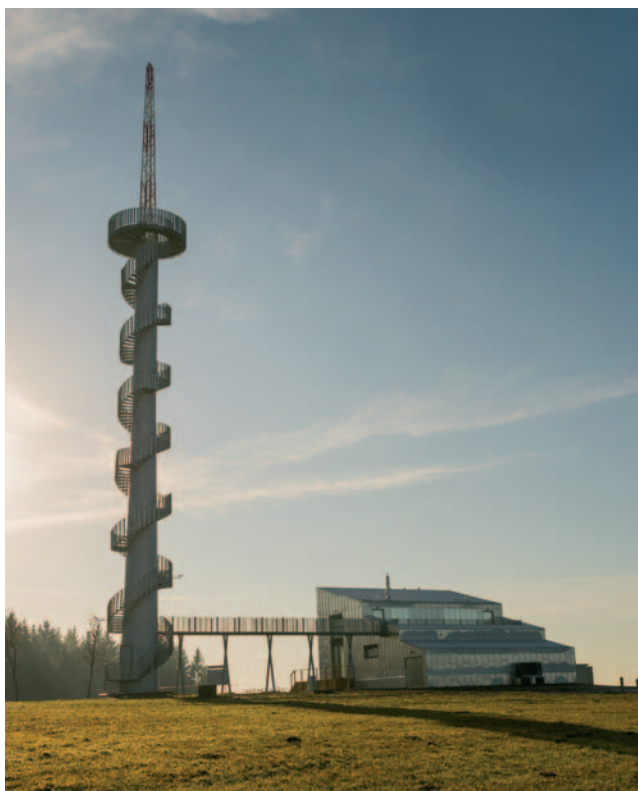
Rozhledna na vrchu Šibeník u Nového Hrádku je držitelem českého rekordu pro první rozhlednu z přestavěné větrné elektrárny. Foto: David Stejskal
