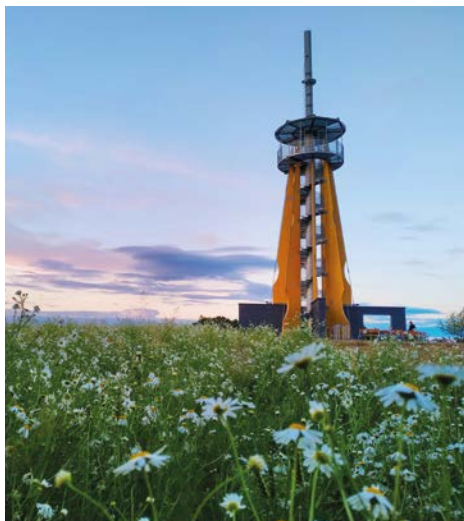
Wieża widokowa „Blahutovice” / Rozhledna „Blahutovice”
